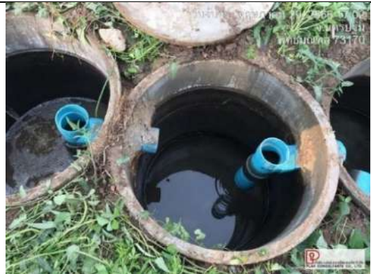
ระบบบำบัดน้ำเสียของพื้นที่ก่อสร้างอาคารหอพักเจ้าหน้าที่ หลังที่ 2
