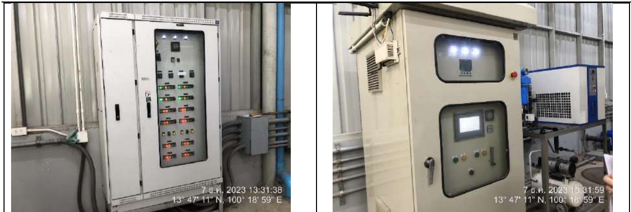
รูปที่ 2-15 การติดตั้งมิเตอร์ไฟฟ้าของระบบบำบัดน้ำเสียและการควบคุมการทำงานของระบบบำบัดน้ำเสีย
