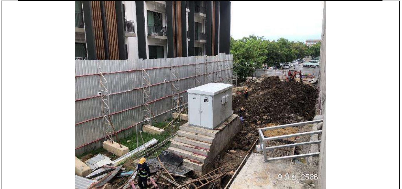
ภาพการเปิดหน้าดินเพื่อติดตั้งระบบบำบัดน้ำเสีย
