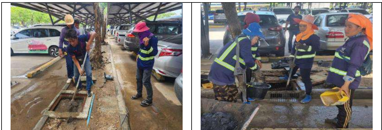
รูปที่ 2-14 การดูแลทำความสะอาด ขุดลอกท่อและระบายน้ำภายในพื้นที่โครงการ
