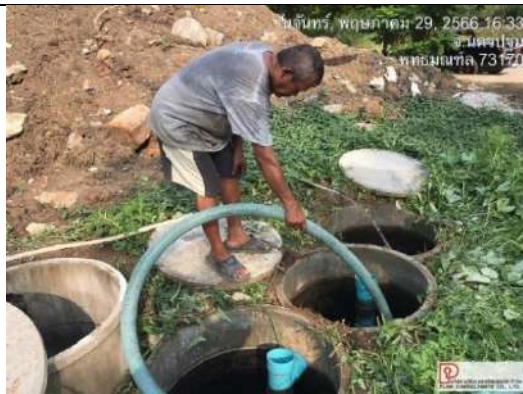
การสูบลากตะกอนระบบบำบัดน้ำเสียของพื้นที่ก่อสร้างอาคารหอพักเจ้าหน้าที่ หลังที่ 2
