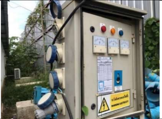
ระบบไฟฟ้าของพื้นที่ก่อสร้างอาคารหอพักเจ้าหน้าที่ หลังที่ 2
