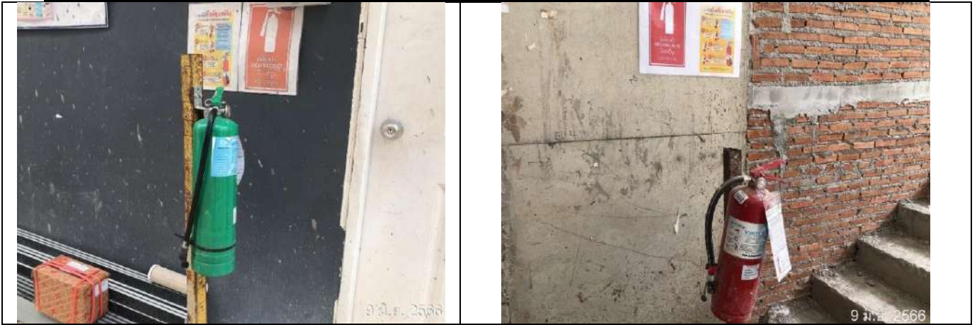
ตัวอย่างการติดตั้งถังดับเพลิงบริเวณพื้นที่ก่อสร้าง
